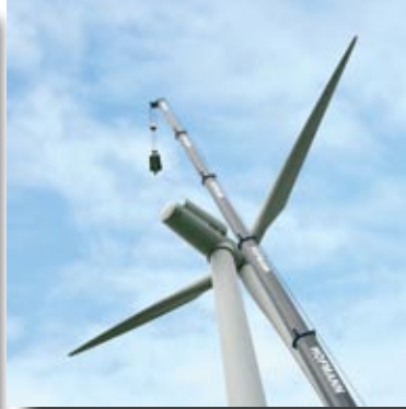
Austausch Windgenerator
